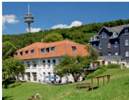
Übergangseinrichtung des WWH, Kelkheim-Eppenhain
