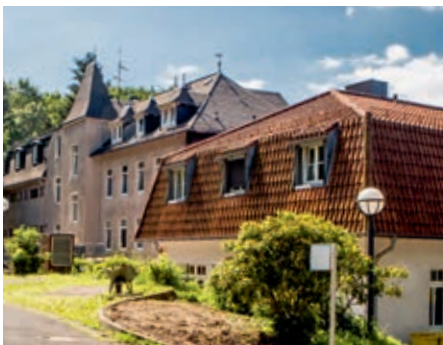
Entgiftungsstation im Wolfgang-Winckler-Haus (WWH), Kelkheim-Eppenhain (Betrieb zum 31.12.2025 eingestellt)
