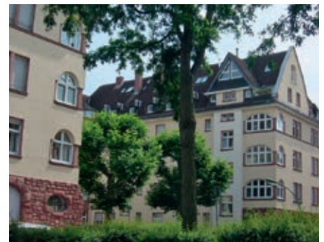
Stationäre Nachsorge Broßwitzstraße, Frankfurt
